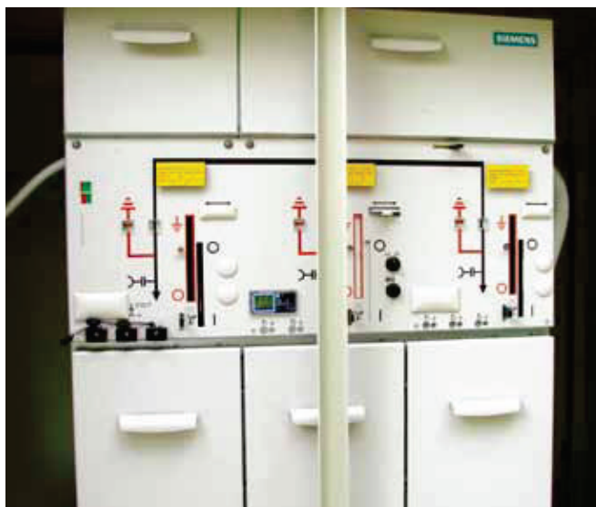
Siemensov SF6 blok.
