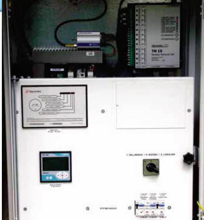
TP je poleg daljinskega vodenja opremljena tudi z zaščito ter meritvami na SN in NN nivoju.
